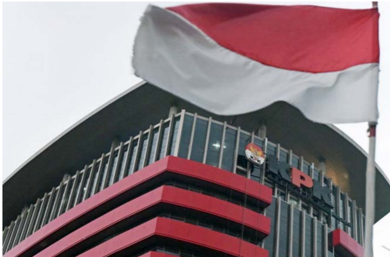
Gambar : Gedung Komisi pemberantasan Korupsi
